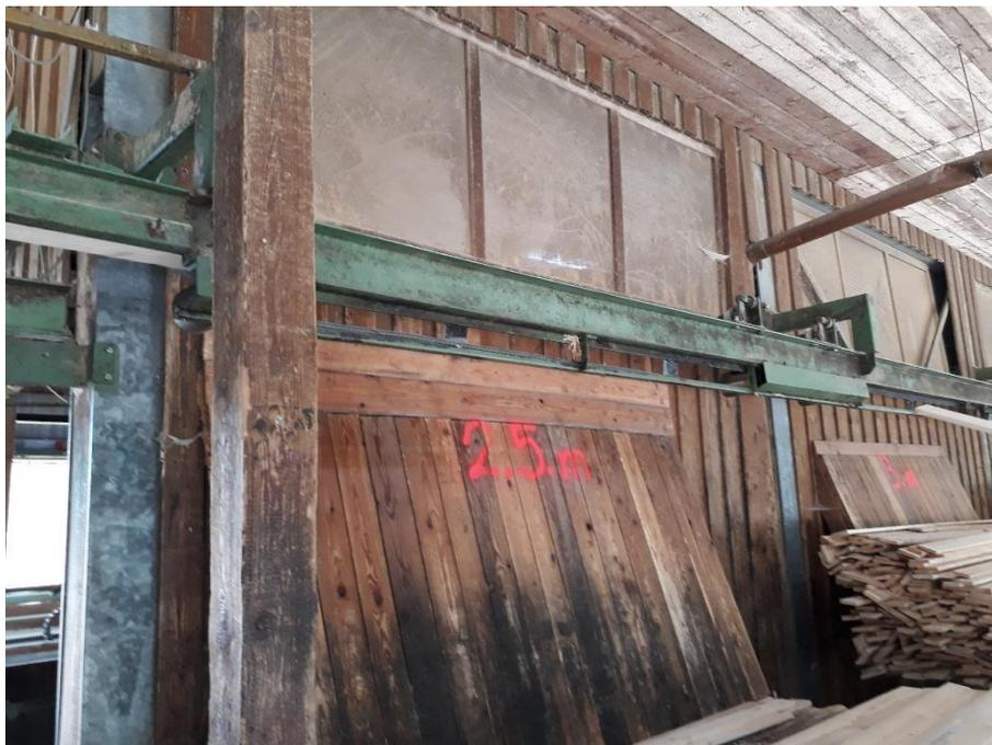
Abbildung 3.5: Westliche Wand der Sägehalle 1 (Holzverschalung mit vorgesetztem Förderband)
